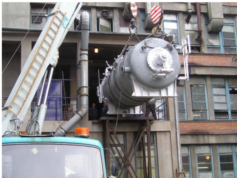
Obr. 11 Instalace vulkanizačního kotle Gumotex Břeclav
