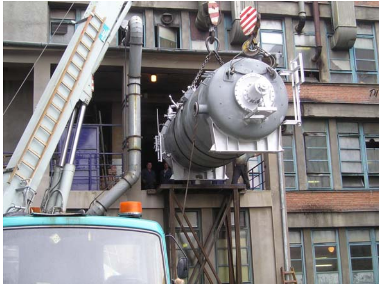
Fig. 11 Autoclave installation, Gumotex Břeclav
