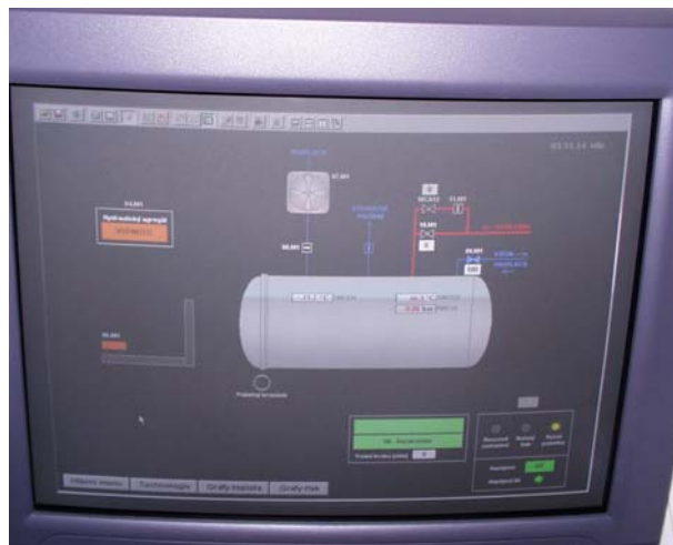
Fig. 8 Control panel view, Autopal Nový Jičín
